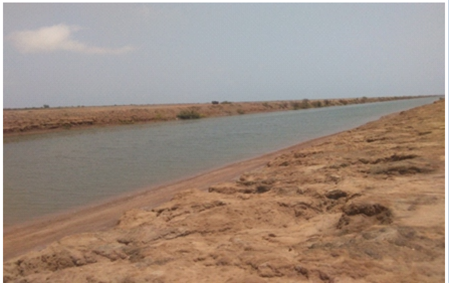
Figura 2. Canal de llamada de agua marina para uso acuícola con 7.5 km de longitud.
