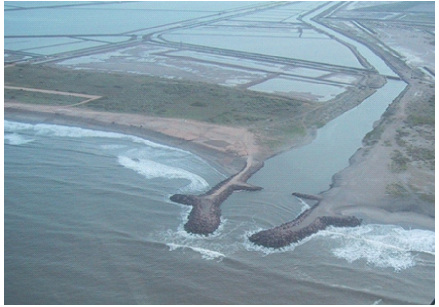
Figura 3. Escolleras construidas en playa de Ponce, Sinaloa, para proteger la boca de un canal de llamada artificial para uso acuícola.
