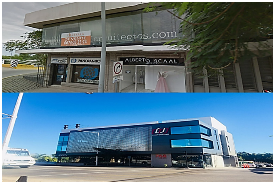
Imagen 20. Antes y después del espacio comprendido como edificio VM
