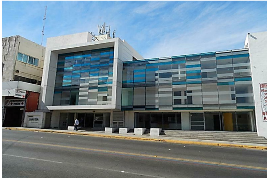
Imagen 19. Edificio Chantal en la actualidad
