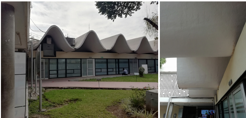
Figura 10. Los cascarones de concreto que evocan la plástica de mediados del siglo xx y especialmente la obra de Félix Candela. Son visibles sólo al interior de la facultad en su área jardín.
