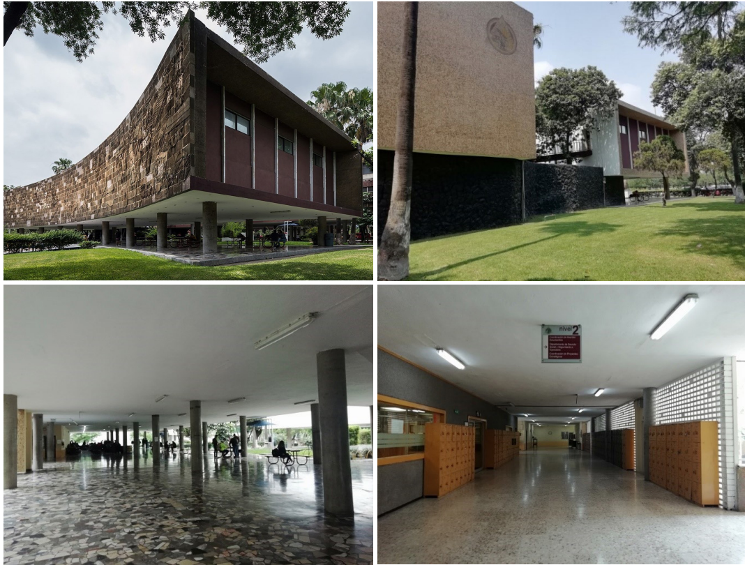
Figura 6. Detalles del exterior e interior de la Facultad de Ingeniería Civil, donde se aprecia su destacada —y única— planta libre, así como la permanencia de materiales originales de construcción.
