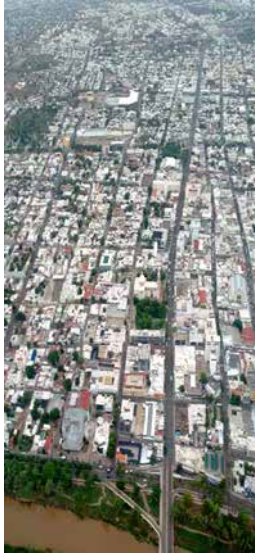
FIGURA 3. VISTA AÉREA DE LA AVENIDA ÁLVARO OBREGÓN TOMADA HACIA EL NORTE. SE ADVIERTE UNA REURBANIZACIÓN CASI COMPLETA. DEBAJO DE LA FOTOGRAFÍA SE VE LO QUE QUEDA DEL RÍO TAMAZULA.
