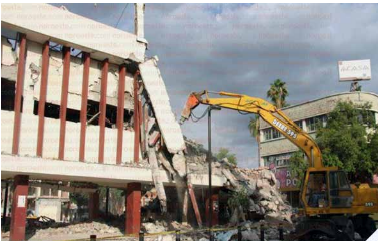
FIGURA 18. DEMOLICIÓN EN 2009 DEL EDIFICIO DEL CINE REFORMA (MODULAR INÉS ARREDONDO) PARA CONSTRUIR EL MUSEO INTERACTIVO SOBRE LAS ADICCIONES.
