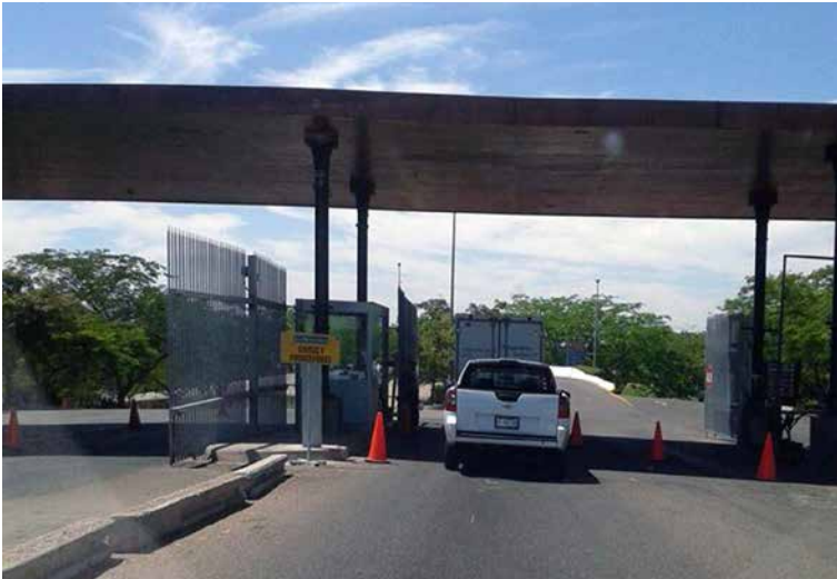
FIGURA 11. ACCESO PRINCIPAL A LA PRIMAVERA DONDE SE TIENEN CÁMARAS DE VIDEOVIGILANCIA Y CONTROL DE GUARDIAS DE SEGURIDAD LAS 24 HORAS.
