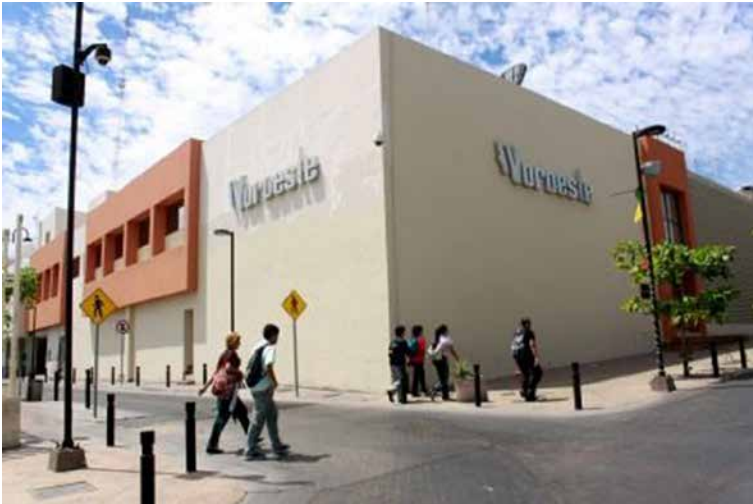
FIGURA 8. EDIFICIO BUNKERIZADO DEL DIARIO NOROESTE CULIACÁN.
