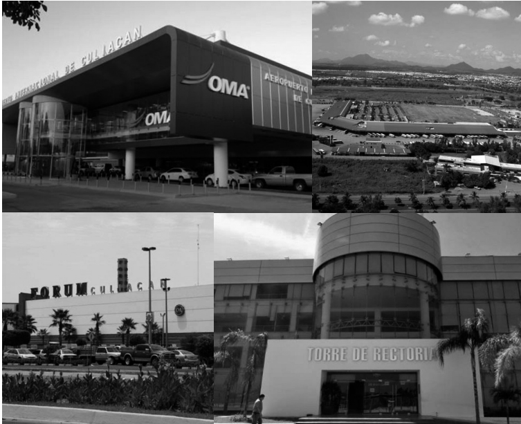
FIGURA 1. IMÁGENES DE LOS NUEVOS EDIFICIOS COMERCIALES Y DE INSTITUCIONES DE SERVICIOS PÚBLICOS.
