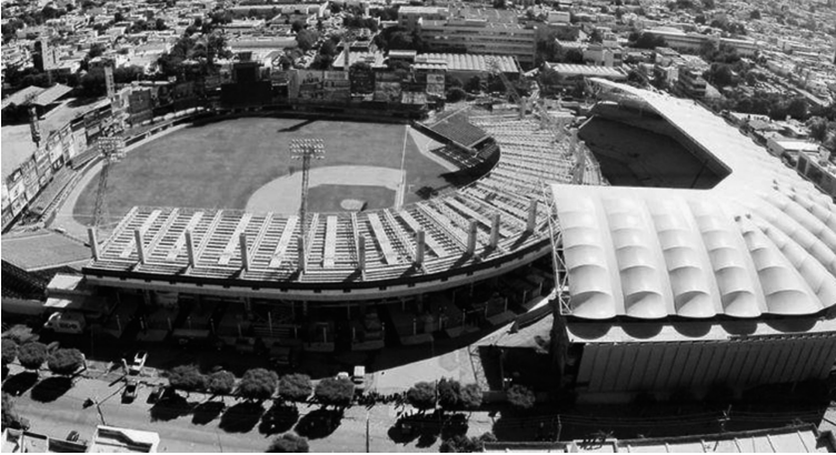
FIGURA 22. VISTA AÉREA DE LA CONSTRUCCIÓN DEL NUEVO ESTADIO DE BEISBOL EN CULIACÁN
