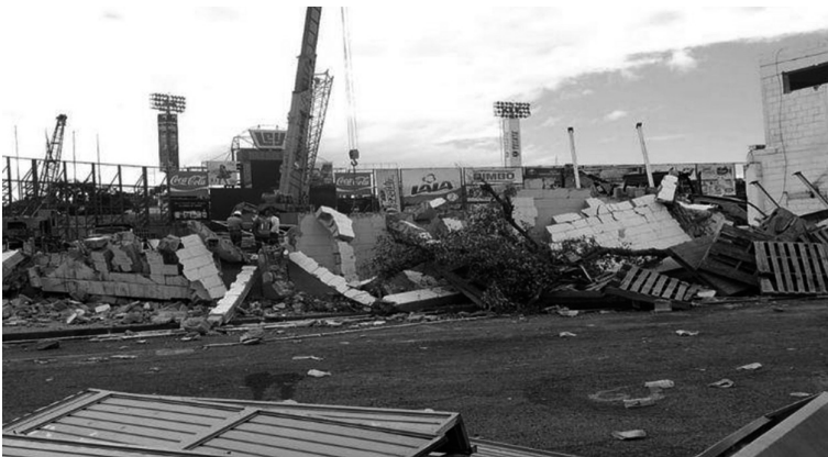
FIGURA 21. DEMOLICIÓN EN 2015 DEL ESTADIO DE BEISBOL ÁNGEL FLORES.
