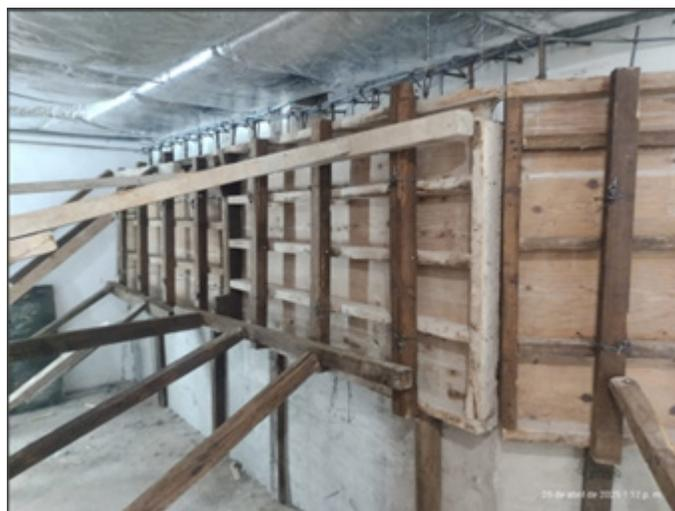
Figura 7. Muro interior cara Oeste en proceso de cimbrado
