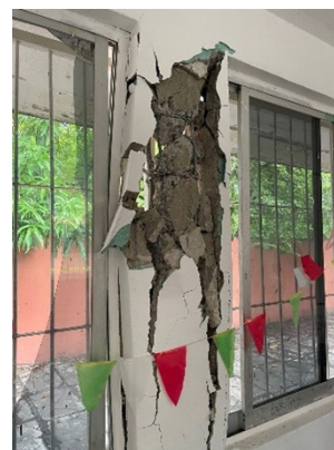
Figura 2 Daño estructural grave por efecto de “columna corta” en escuela de un nivel en Tecomán, Colima, debido al temblor del 19 de septiembre de 2022 (tomadas de: Vizcaino, 2022).
