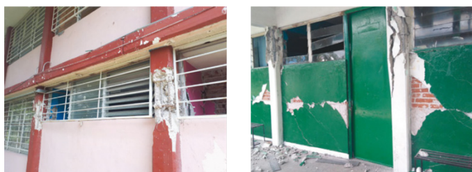
Figura 1 Edificios escolares con daño grave debido a falla por cortante en “columnas cortas” en la planta baja debido al temblor del 19 de septiembre de 2017 (tomadas de: García-Carrera et al., 2018).
