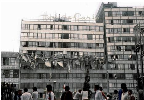
**Fotografía 1. Colapso del entrepiso de un edificio en la Ciudad de México producto del golpeteo durante el sismo del 19/09/85.**
