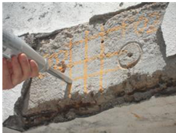
Figura 8. Ensayo de esclerometría
