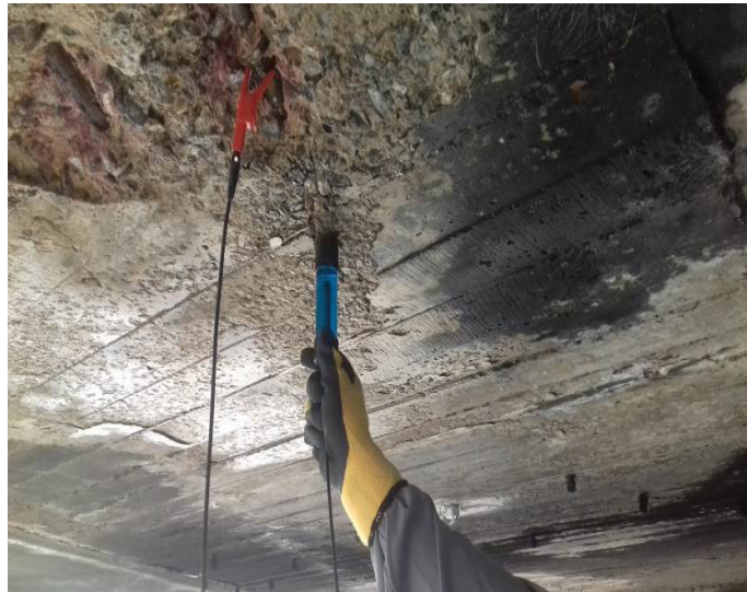
Figura 16. Evaluación del potencial de corrosión en armaduras de tablero
