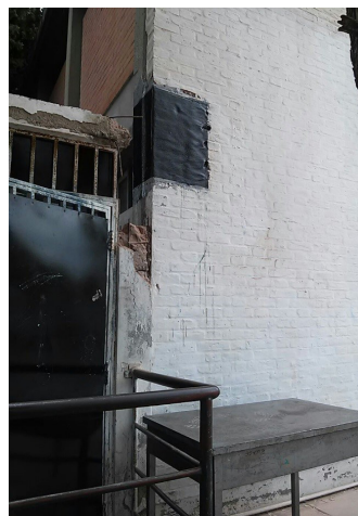
Figura 8 (h). Sistema de refuerzo con FRP (refuerzo de columna corta en extremos)
