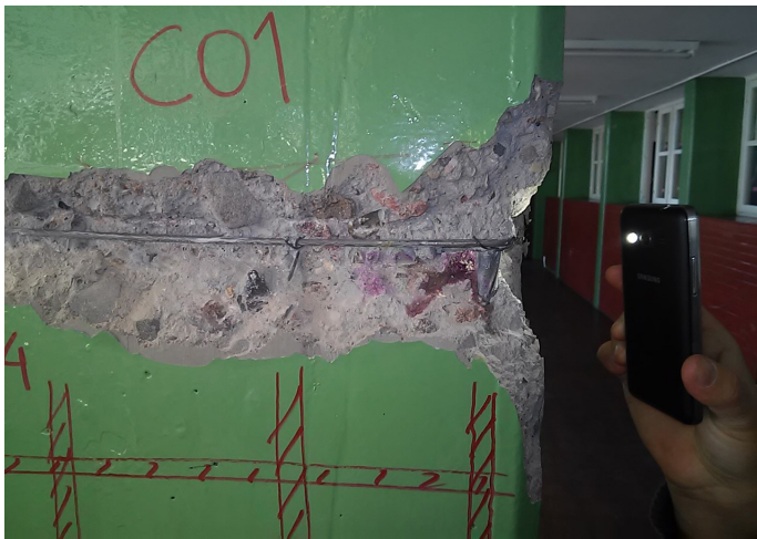
Figura 6. Estudio de verificación de armadura
