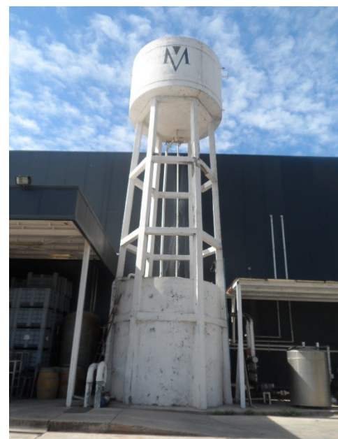
Figura 5. Estructura de concreto reforzado para sostenimiento de tanque elevado
