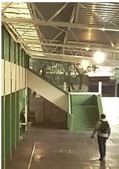
Figura 1 (c). Edificio escolar (escalera)
