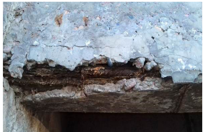
Figura 2. Fisuración y desprendimiento del concreto por corrosión del acero
