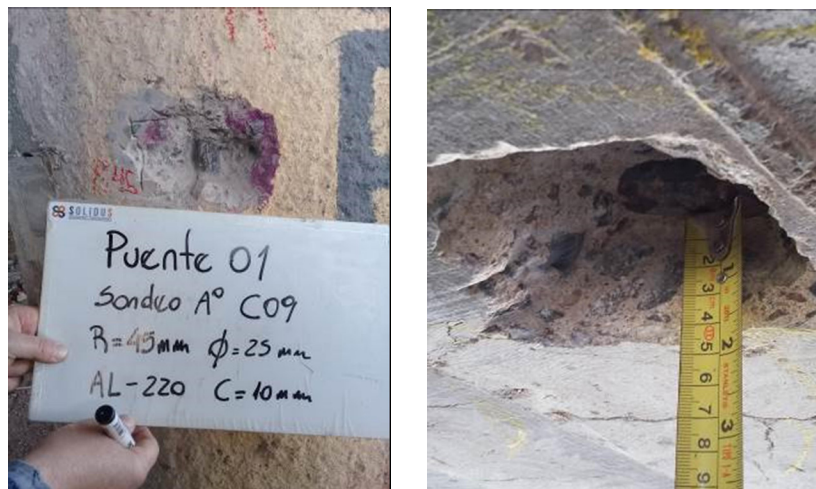
Figura 12. Sondeo mecánico de armaduras en columna y en tablero
