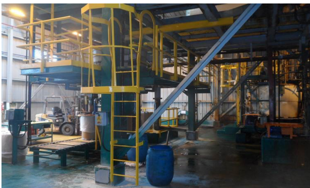
Figura 18. Bases y losa de concreto reforzado evaluadas en el sector industrial
