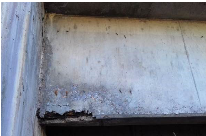
Figura 2. Fisuración y desprendimiento del concreto por corrosión del acero
