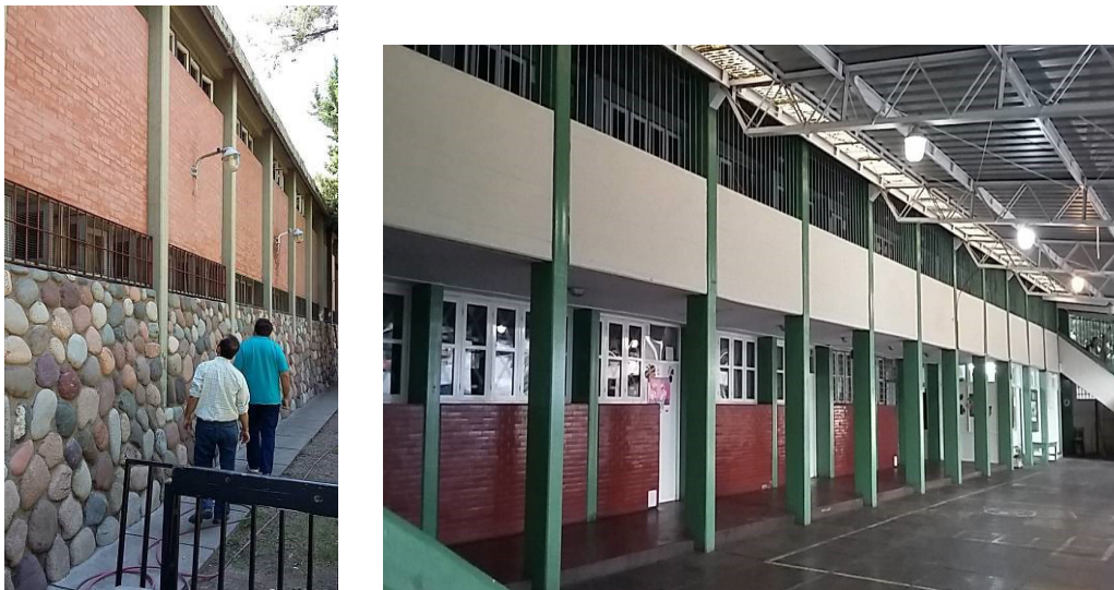
Figura 1 (a). Edificio escolar (fachada y sector galería)
