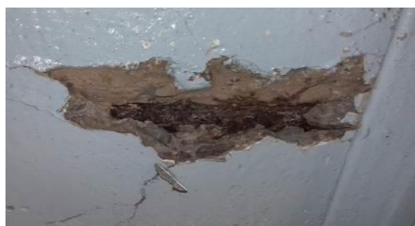
Figura 21. Detección de armadura en pedestal
