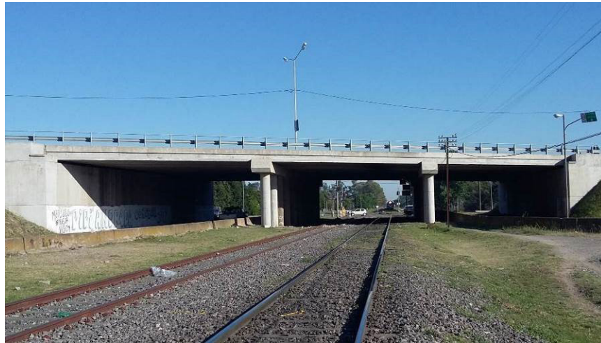
Figura 10. Puente vial evaluado
