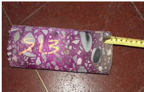
Figura 3. Determinación del frente de carbonatación mediante fenolftaleína
