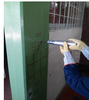
Figura 2. Ensayo de esclerometría
