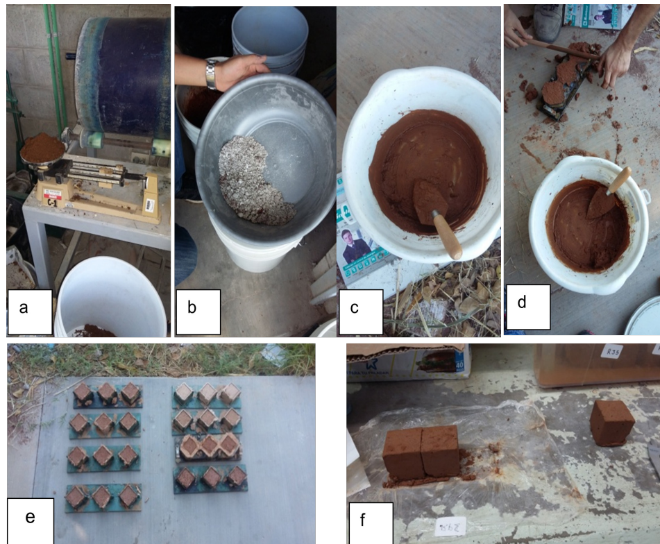
Figura 4. Proceso de mezclado y elaboración del mortero arcilla-cal-cemento-rastrojo de maíz.
